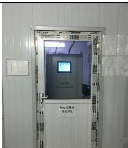
DA006 排气筒在线监测房
