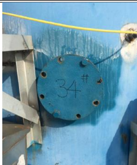
现有 DA006 排气筒采样口
