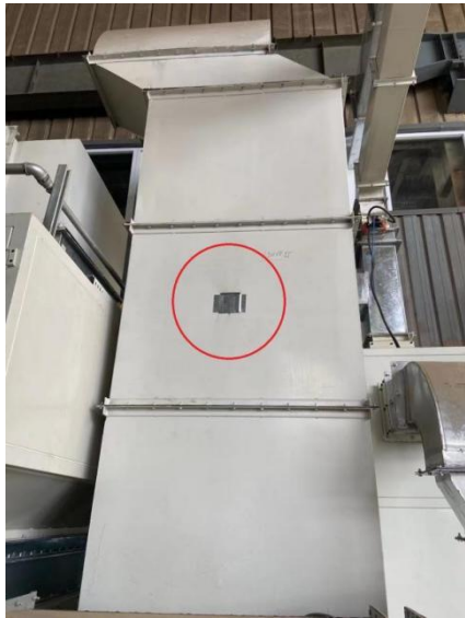
中涂房和干磨房废气入活性炭吸/脱附+催化燃烧装置进口
