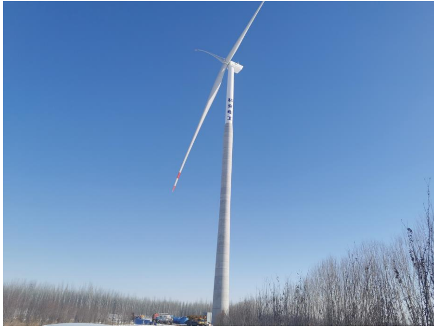
风机建设情况
