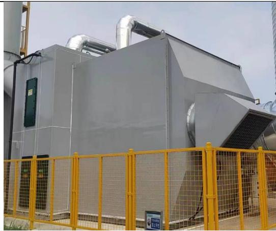
喷漆废气治理设施“沸石转轮+催化燃烧装置”
