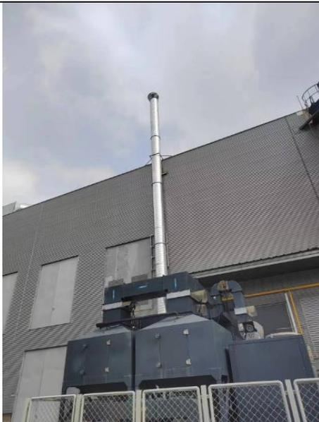
调漆、烘干有机废气排气筒 P29
