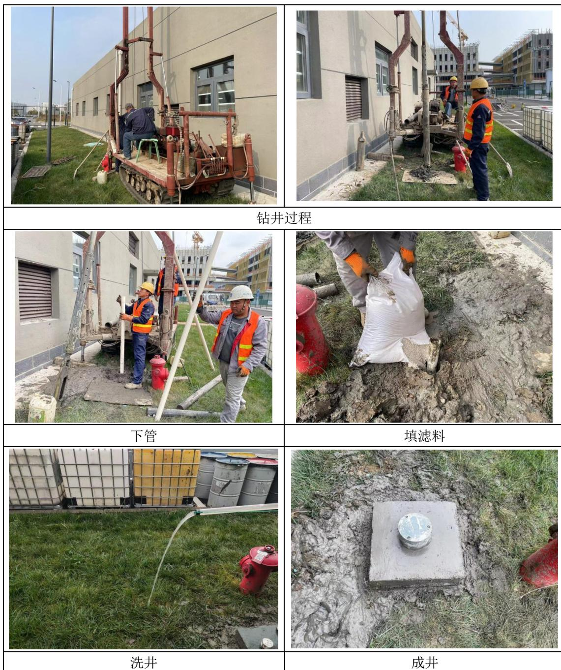
图 5.7-2 水文地质钻探施工及试验过程照片
