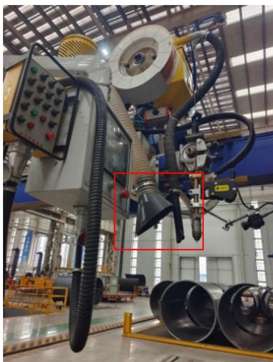
小径管外环缝焊接机废气收集
