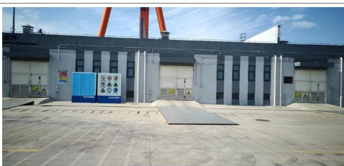
危险废物暂存间
