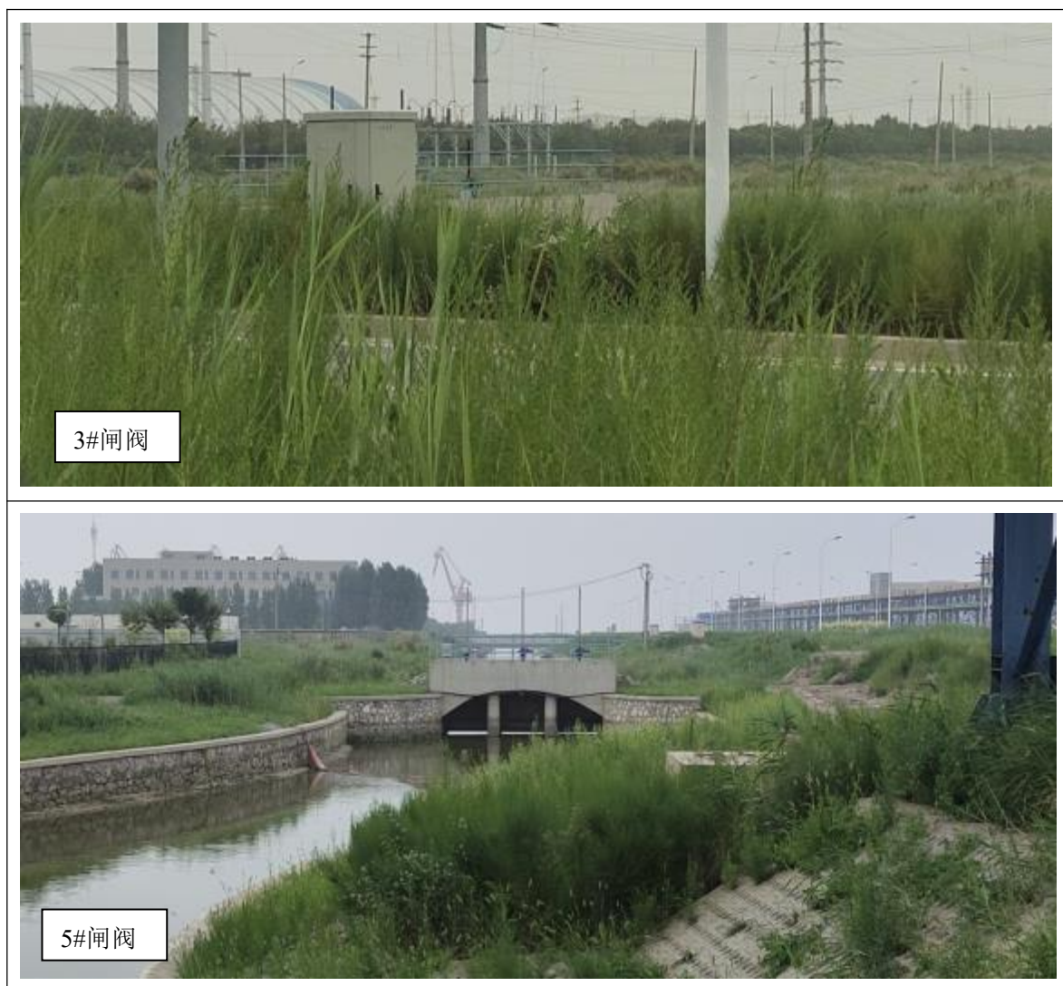
图 6-2 部分已有闸阀照片
