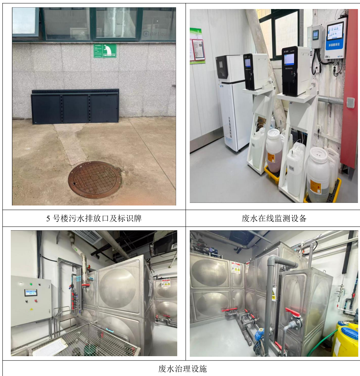
图 4.1-2 废水处理设施及排污口规范化
