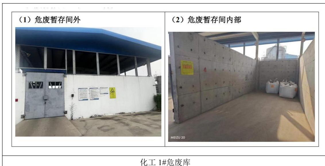
图 2.11-3 危废暂存间规范化设置情况照片
