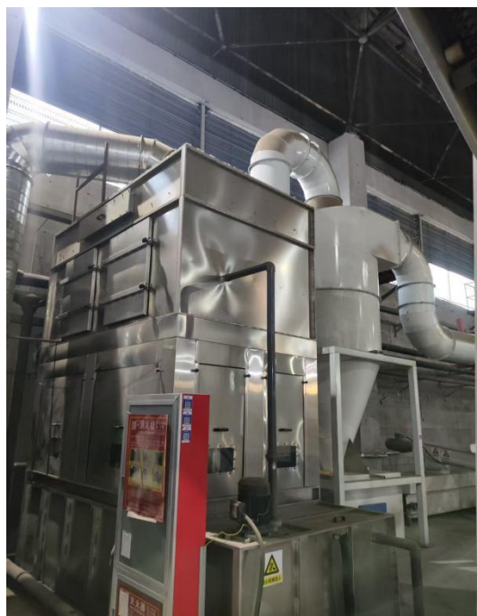
“旋风除尘+水喷淋塔”处理设备
