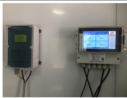
pH 在线监测设备、流量在线监测设备
