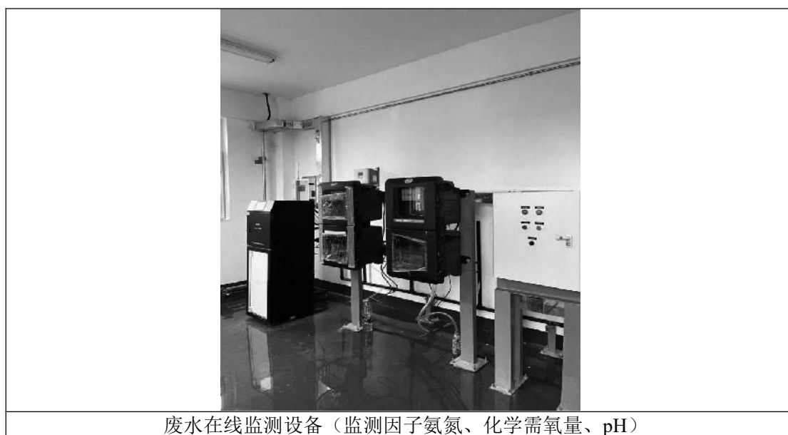
图4.2-2 厂区内在线监测设施照片
